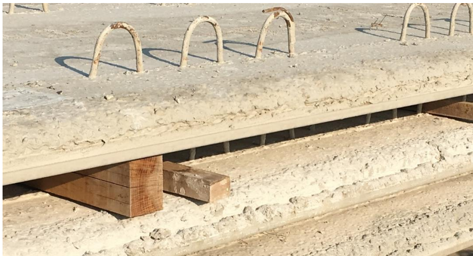
Obr. 9 – bok dílce Presto – přirozeně drsný vlivem výrobního procesu + detail spřahovacích spon
