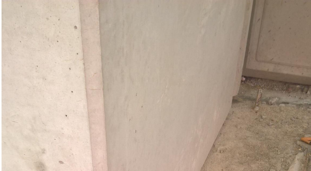
Obr. 23 – hrana tvarovaná pomocí trojúhelníkové lišty
