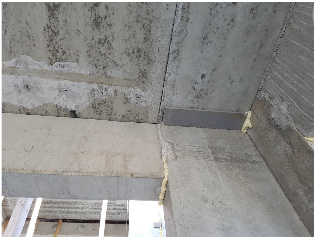
Obr. 20 – uložení dílce Spiroll na ocelovou konzolku, úprava spáry mezi průvlakem a sloupem, odvodňovací otvory v dílci Spiroll, rozdíly v jednotnosti barevného tónu
