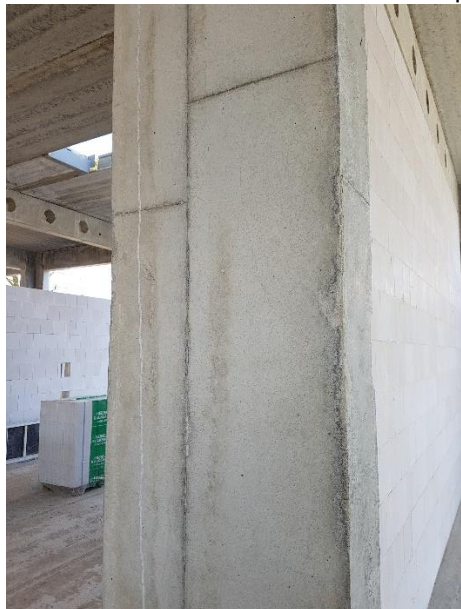
Obr. 21 – ukázka povrchu prefabrikátu ze strany od bednění – napojení bednicích dílců
