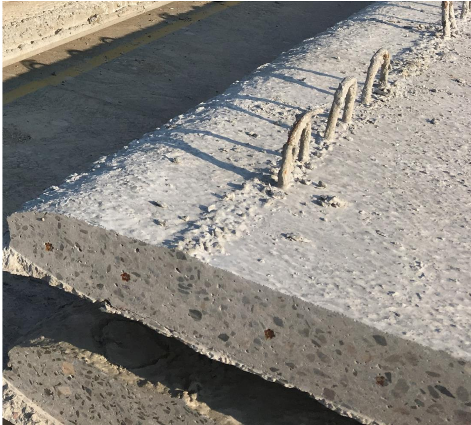
Obr. 8 – horní líc dílců Presto – hrubý povrch
