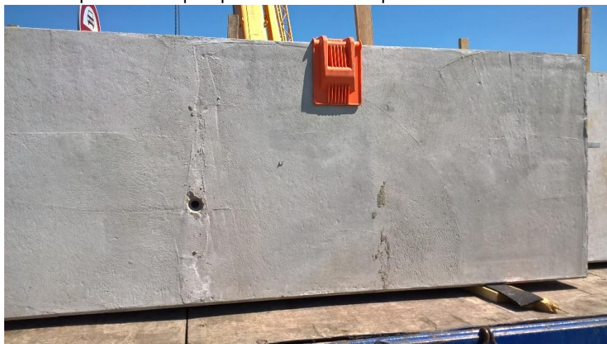
Obr. 22 – ukázka hlazeného povrchu prefabrikátu
