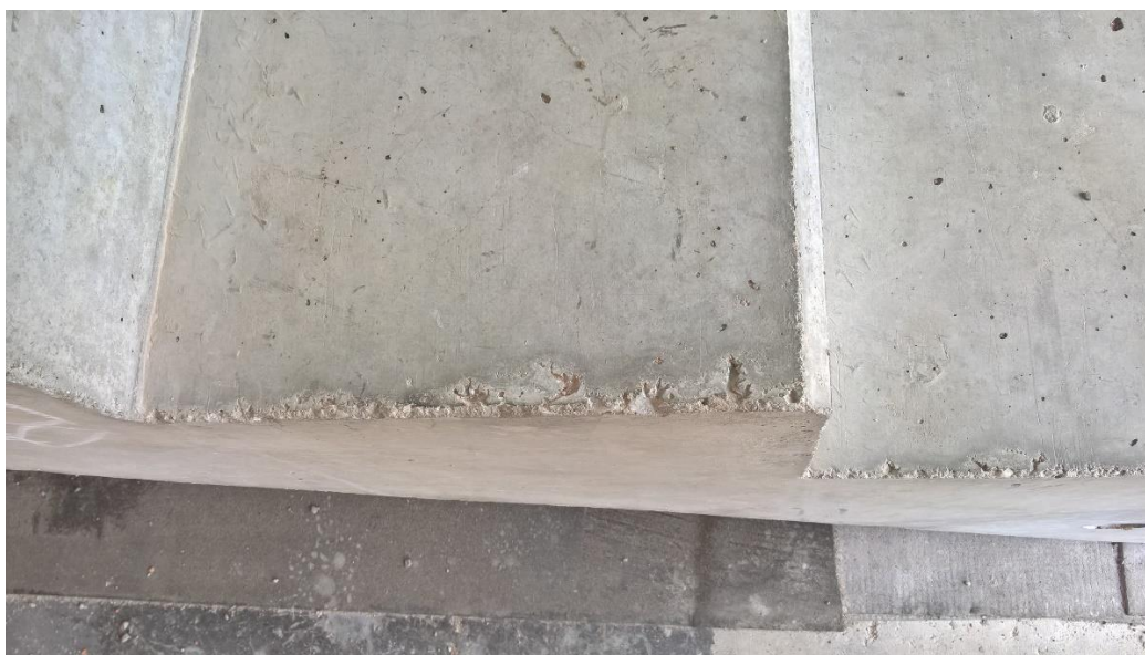
Obr. 12 – boční a vrchní hrana schodišťového dílce
