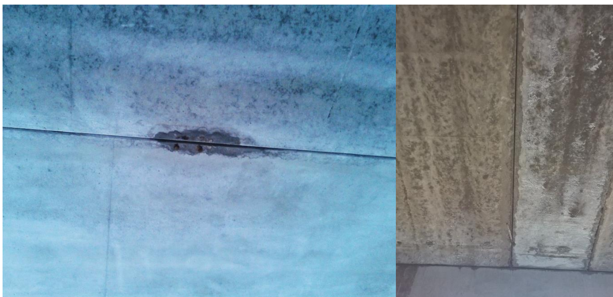
Obr. 6 – výhraby v dílcích Spiroll
