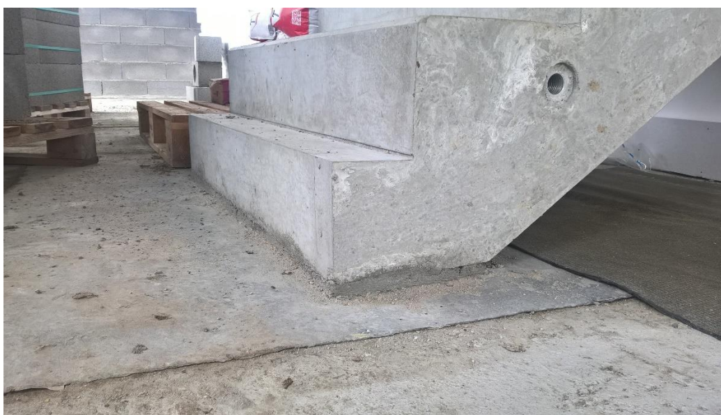
Obr. 13 – bok schodišťového dílce včetně manipulačního závěsu
