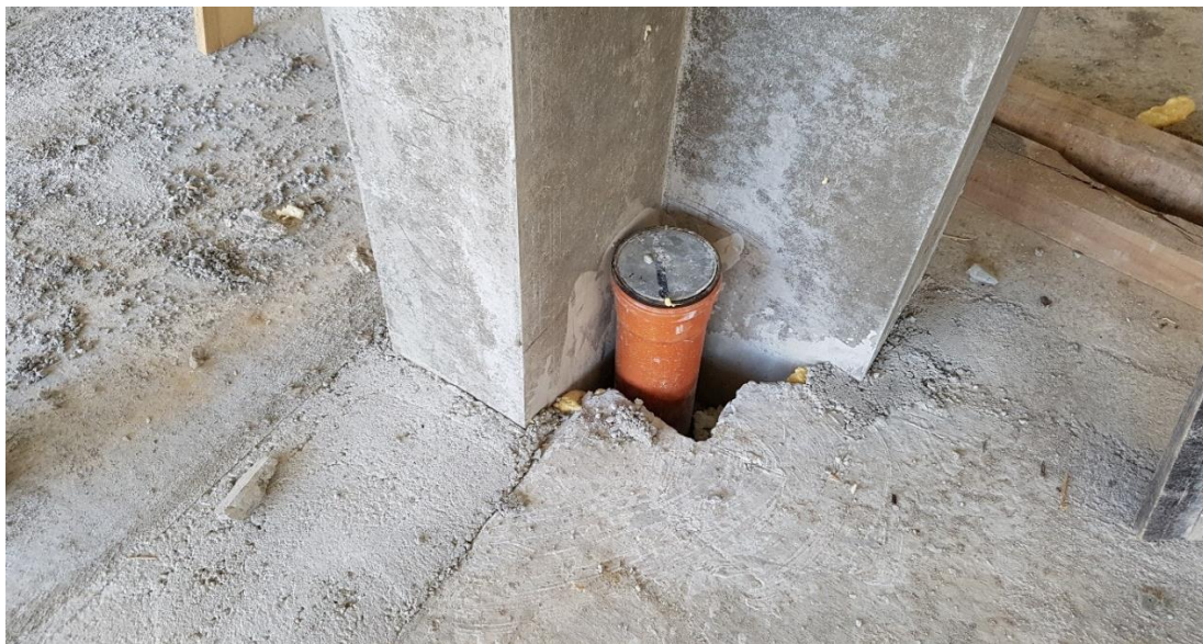
Obr. 6 – výhraby v dílcích Spiroll
