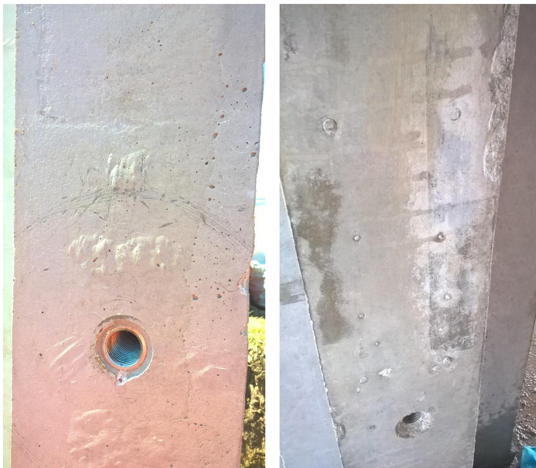
Obr. 20 – ukázka povrchu prefabrikátu ze strany od bednění
