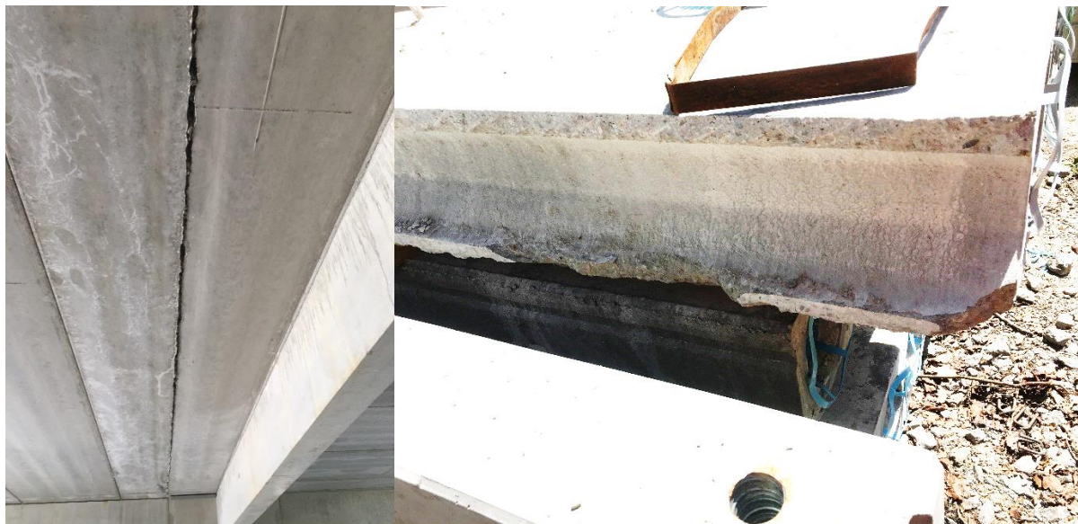
Obr. 5 – řezaná hrana dílce Spiroll
