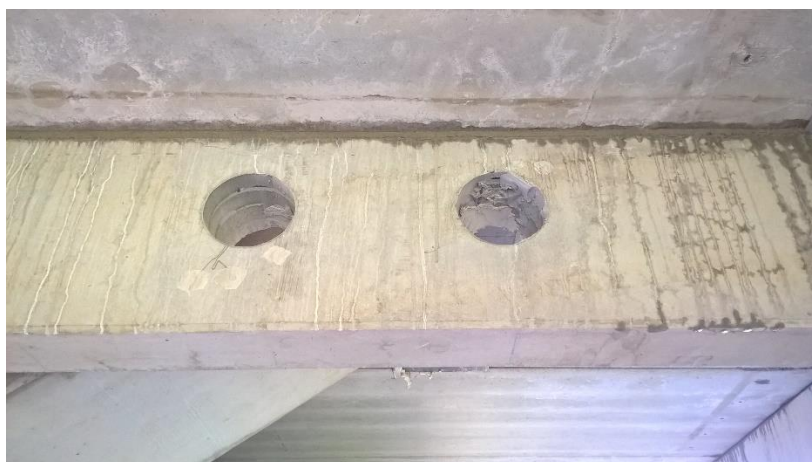
Obr. 18 – ukázka otvoru / prostupu v průvlaku
