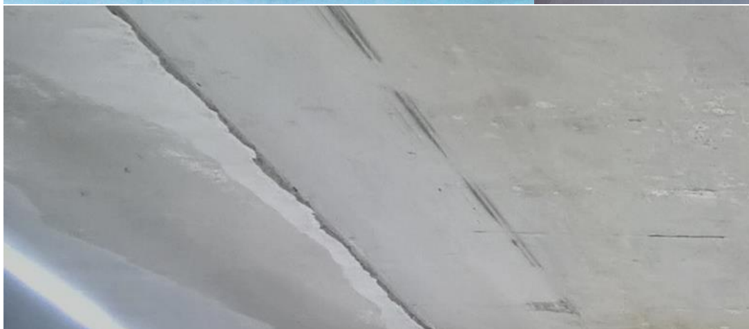
Obr. 7 – spodní líc dílců Presto – rozdíly v jednotnosti barevného tónu, protečení vody spárou, spára mezi doplňkovými šířemi
