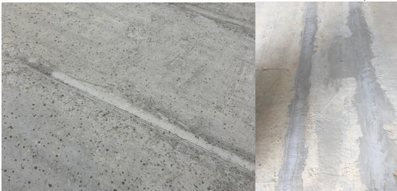
Obr. 3 – horní líc dílců Spiroll – zvlněný povrch
